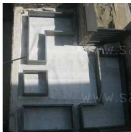
نصب لایه‌های بام سبز و جداکننده‌های فلزی
