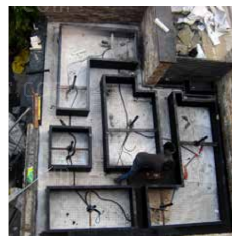
نصب تاسیسات مکانیکی و الکتریکی و BMS
